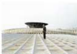
Palasport Genova, architettura dell'architetto Franco Albini, che fu il primo a essere costruito in cemento armato prefabbricato.
