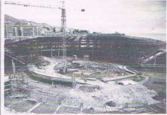
Una rara immagine del cantiere per la costruzione del Palasport
